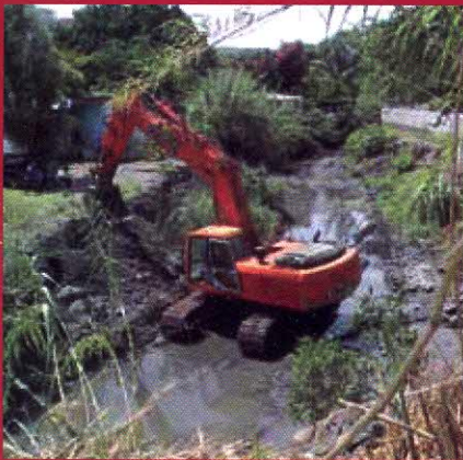
Gracias a los trabajos de limpieza de ríos y barrancas, en Ayala el temporal de lluvias no ha registrado problemas por inundaciones.
