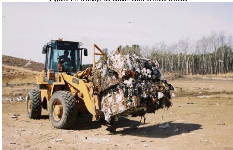
Figura 14. Manejo de pacas para el relleno seco
