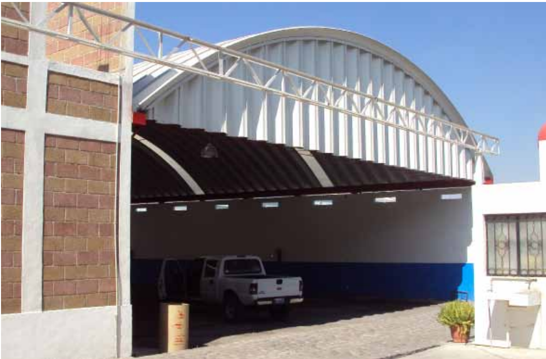
Verificentro en remodelación.
