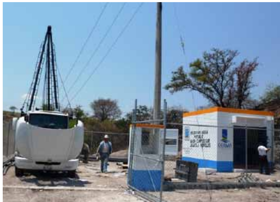
Perforación y equipamiento del pozo "El Jicarero" para agua potable al campus sur de la Universidad Autónoma del Estado de Morelos.
