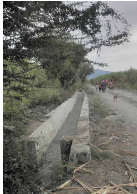
Rehabilitación canal de riego en Huatecalco, Municipio de Tlaltizapán.
