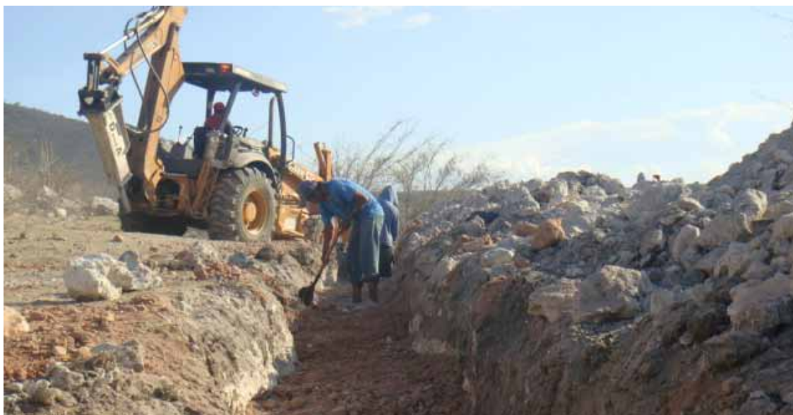
Construcción de la segunda etapa de la red de agua potable Los Presidentes.
