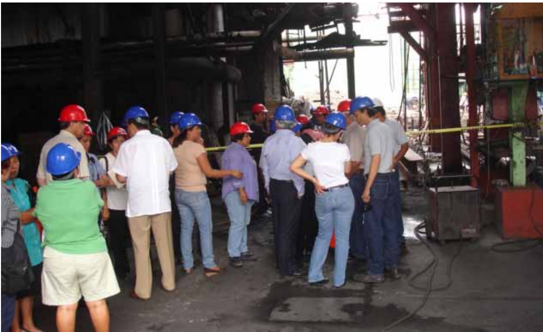
Caldera nueva en el Ingenio Emiliano Zapata de Zacatepec.
