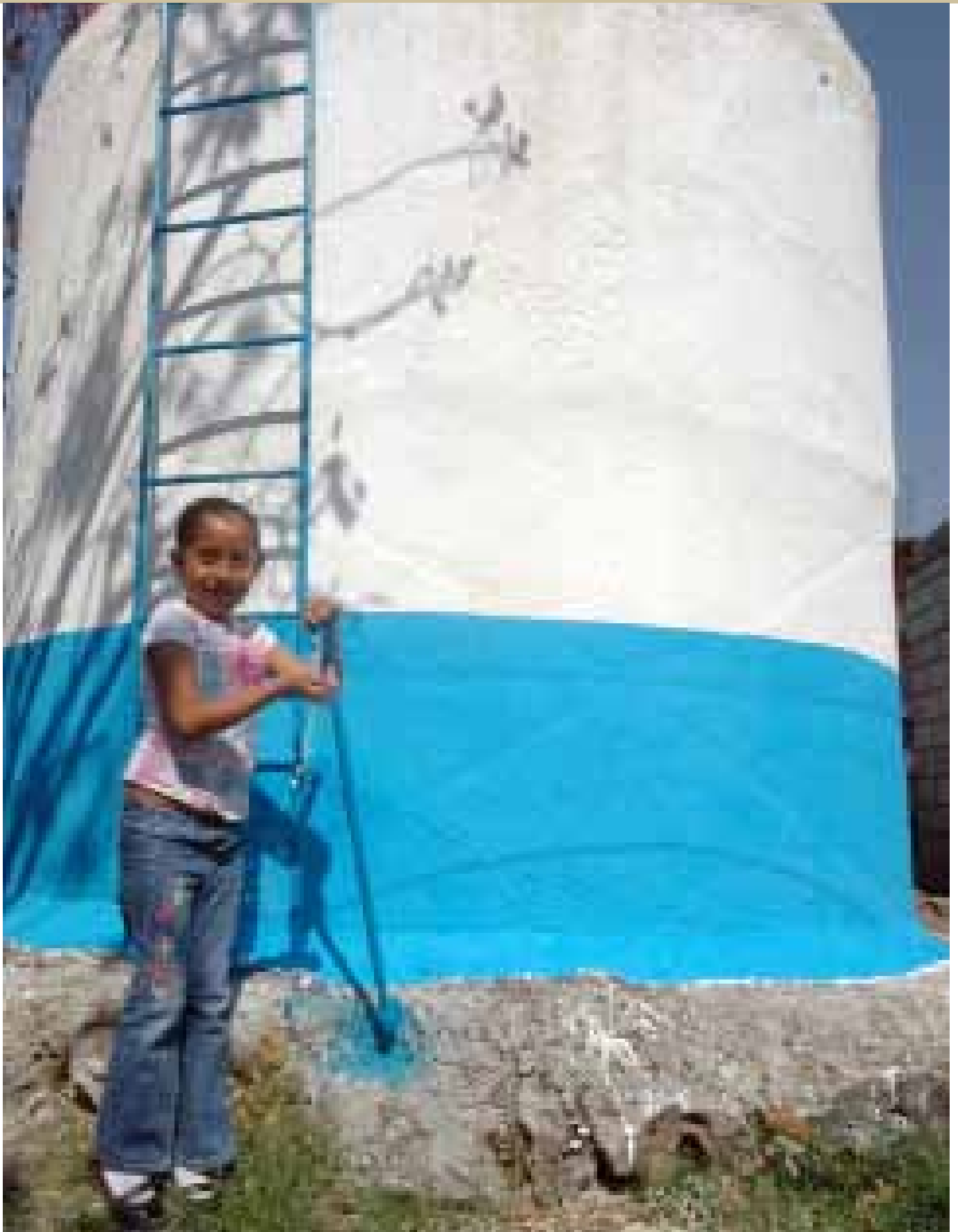
Construcción de cisternas domiciliarias.
