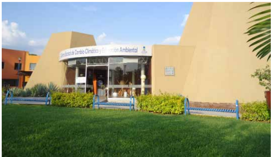
Vista externa del Centro de Cambio Climático.
