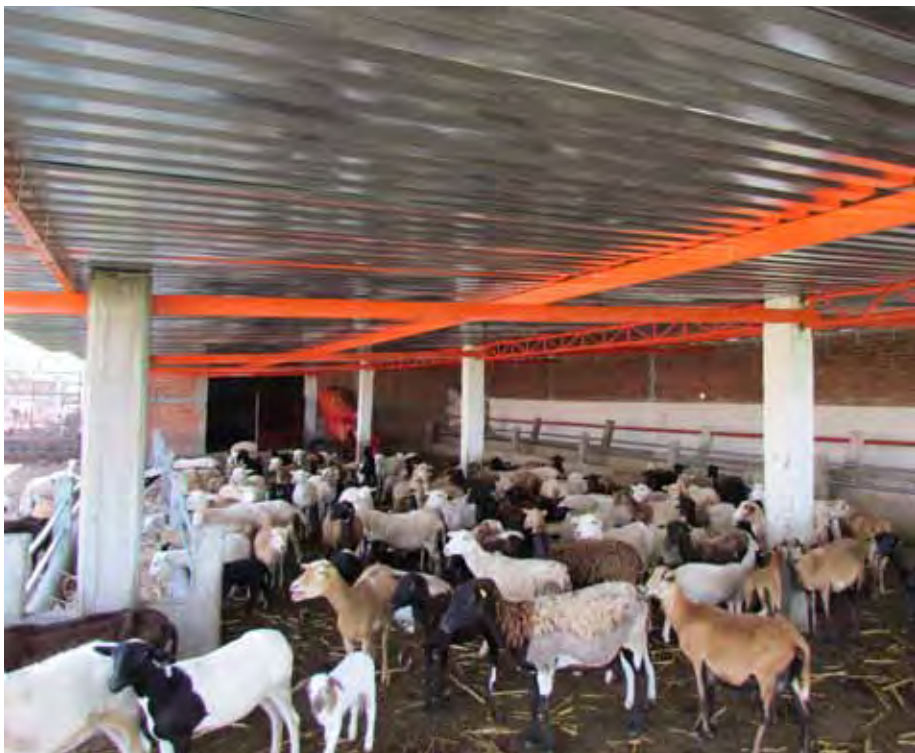
Construcción de corrales para cría de ovinos.
