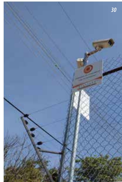
27 a 30) Instalación de cámaras de videoseguridad y rehabilitación de la malla electrificada en la Primaria Amador Salazar, en la Col. Vicente Estrada Cajigal.
